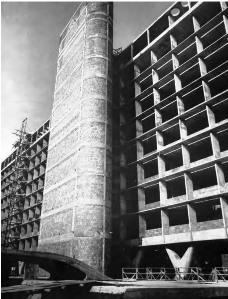
Abb. 24: Oscar Niemeyer, Hospital da Lagoa, Teilansicht von der Strassenseite mit Aufzug- und Treppenturm im Bau (Papadaki 1962, Abb. 69).
