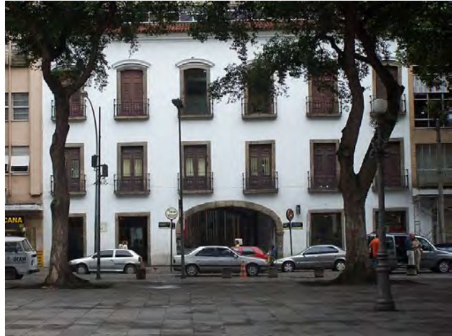
Abb. 9: Arco do Teles, heutiger Zustand ( http://pt.wikipedia.org/wiki/Ficheiro:Rio-ArcoTeles.JPG am 17.11.2013).
