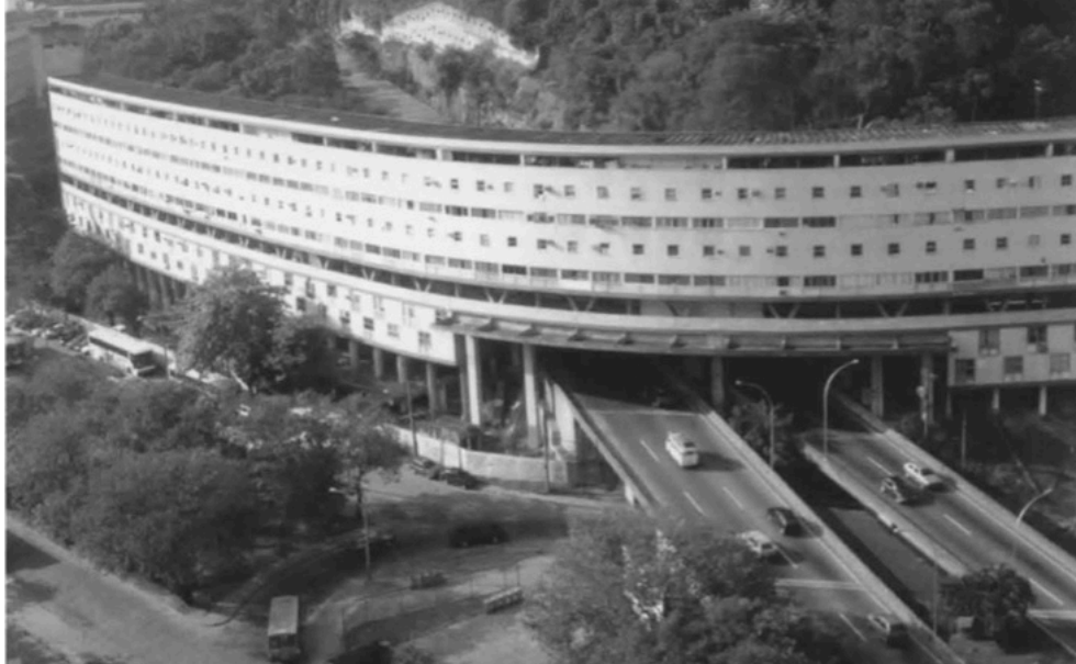
Abb. 13: Marquês de São Vicente, Ansicht von Süden nach dem Durchbruch für die Schnellstrasse (Bonduki 2000, S. 112).
