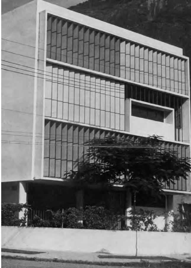
Abb. 20: Oscar Niemeyer, Obra do Berço, 1937, Ansicht von Osten (Mindlin 1956, S. 145).
